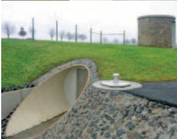
Rysunek: Studnia wodomierzowa (po lewej) i komora wody (po prawej)
