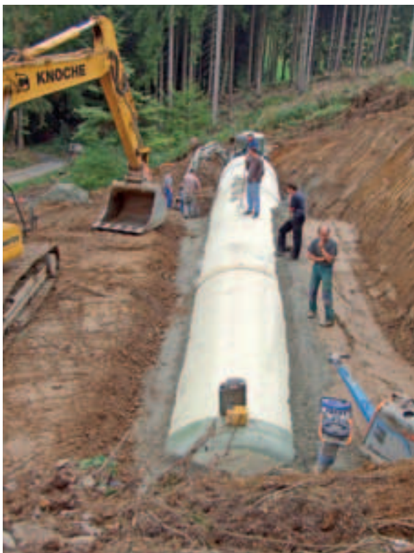
Zdjęcia i rysunek: Konstrukcja naziemnego zbiornika wody pitnej w Brabecke jako system jednoliniowy
