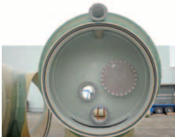
Zdjęcie: Prefabrykowane moduły GRP – przejście z komory roboczej do komory wody – średnica DN 3000 dla zbiornika wody pitnej w Klettwitz
