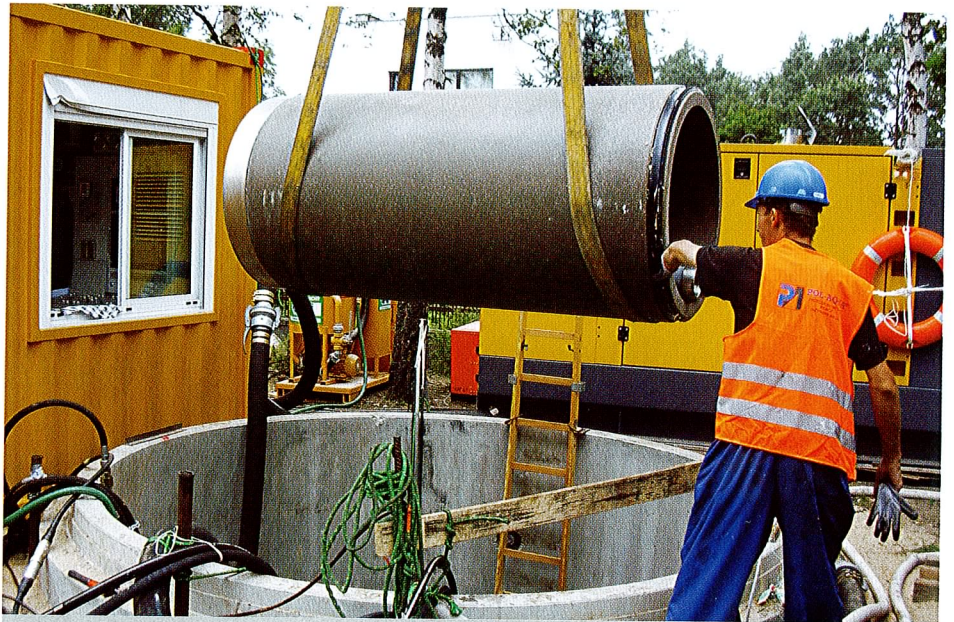
Fot. 1. Rurociąg z polimerobetonu przeciskowego DN800/960 w odcinkach 2 m
