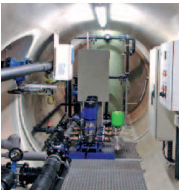
Zbiornik tłoczny z wejściem od strony czołowej
