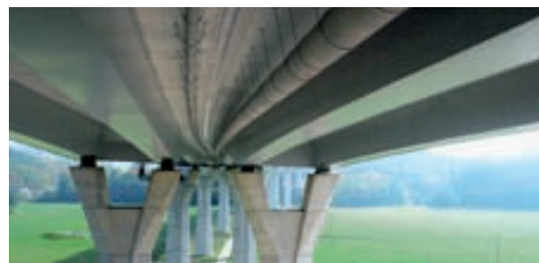
Rurociąg odwadniający konstrukcję mostową
