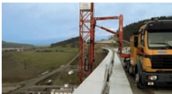
Montaż przy pomocy urządzenia do prac bezpośrednio pod obiektem mostowym
