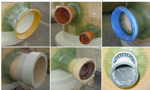
Rysunek 4-3-1 Przykłady połączeń studni z innymi materiałami
