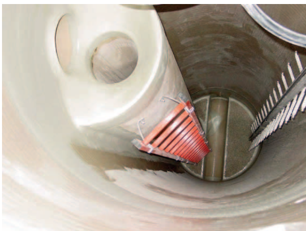
Zdjęcie 4-5-1 Studnia z wewnętrznym przepadem
